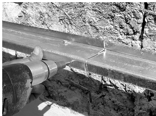
Napojení profilů Z50, velikost přesahu je 100 mm.
