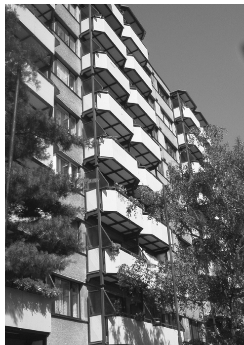
Nosná konstrukce a kotevní výplně zábradlí – deska CETRIS® tl. 16 mm
