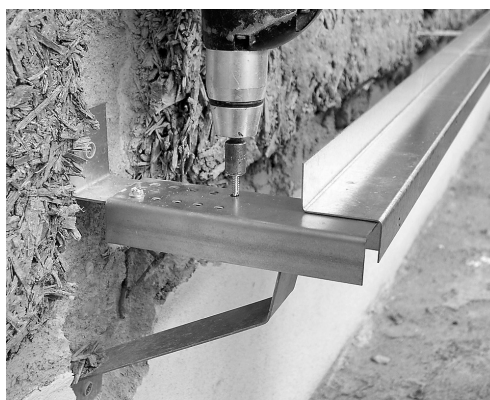
Použití rektifikačního profilu
