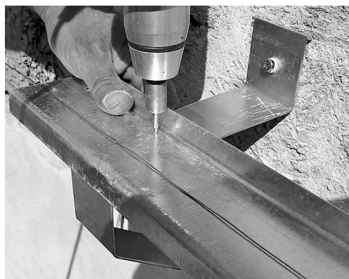
Napojení profilů Z50, velikost přesahu je 100 mm.
