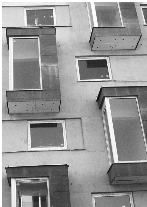
Nosná konstrukce a kotevní výplně zábradlí – deska CETRIS® tl. 16 mm
