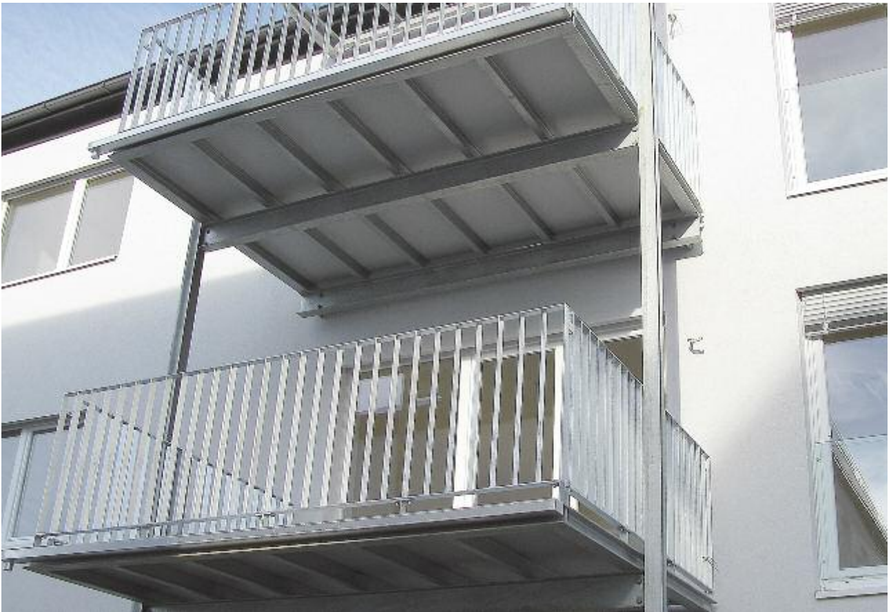
Balkonové podlahové desky; Objekt v St. Veit/Glan, Rakousko
