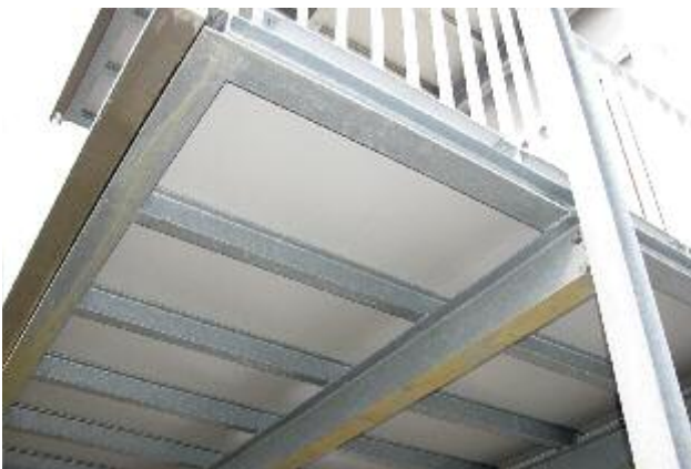
Spodní konstrukce / nosníky
