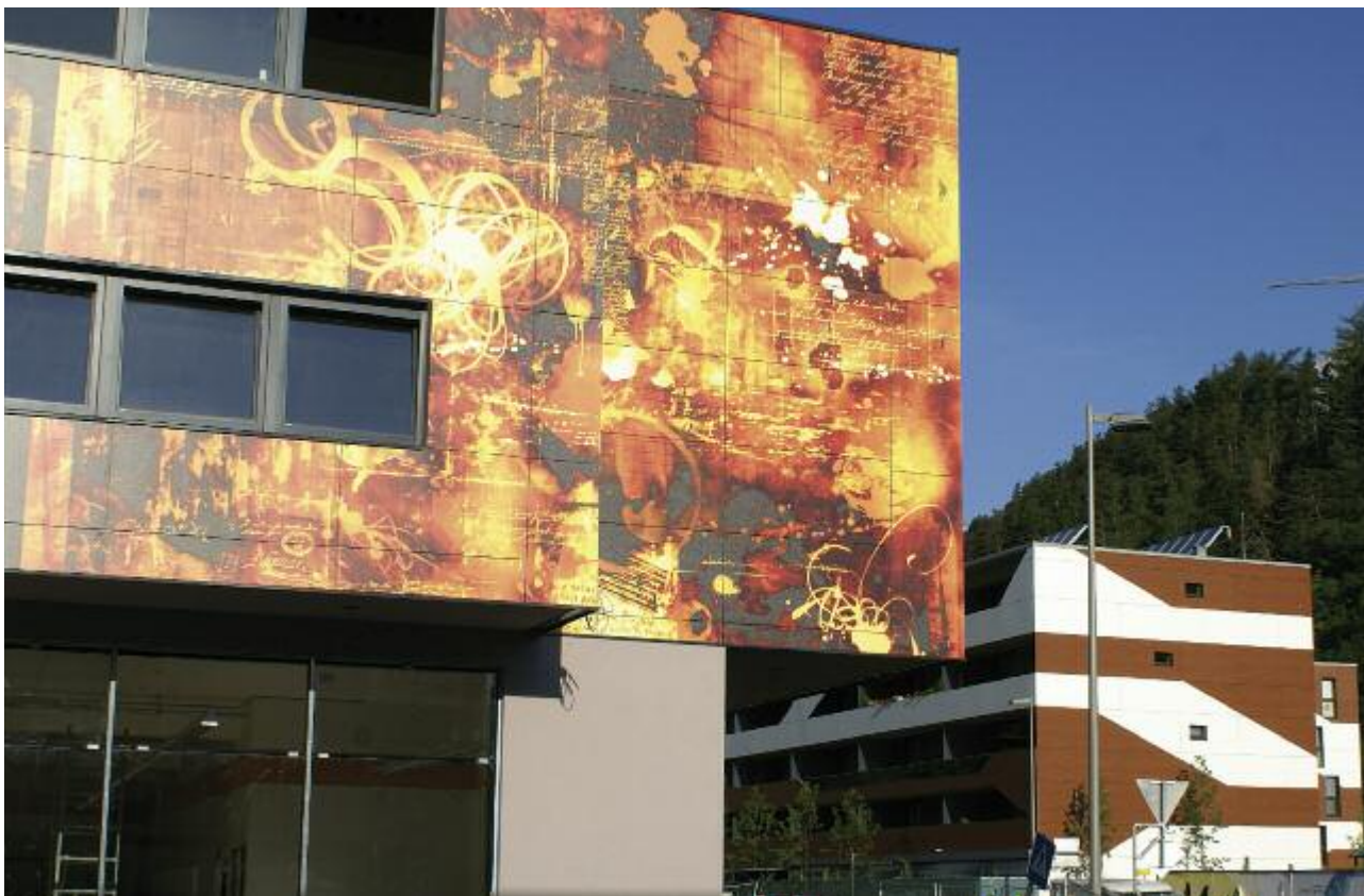
Kancelářská budova, Landeck, Rakousko
