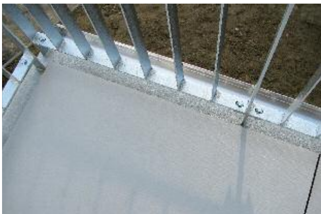
Venkovní roh a hrana
