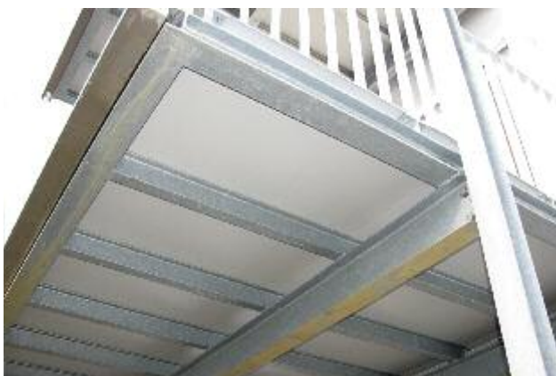
Spodní konstrukce / nosníky
