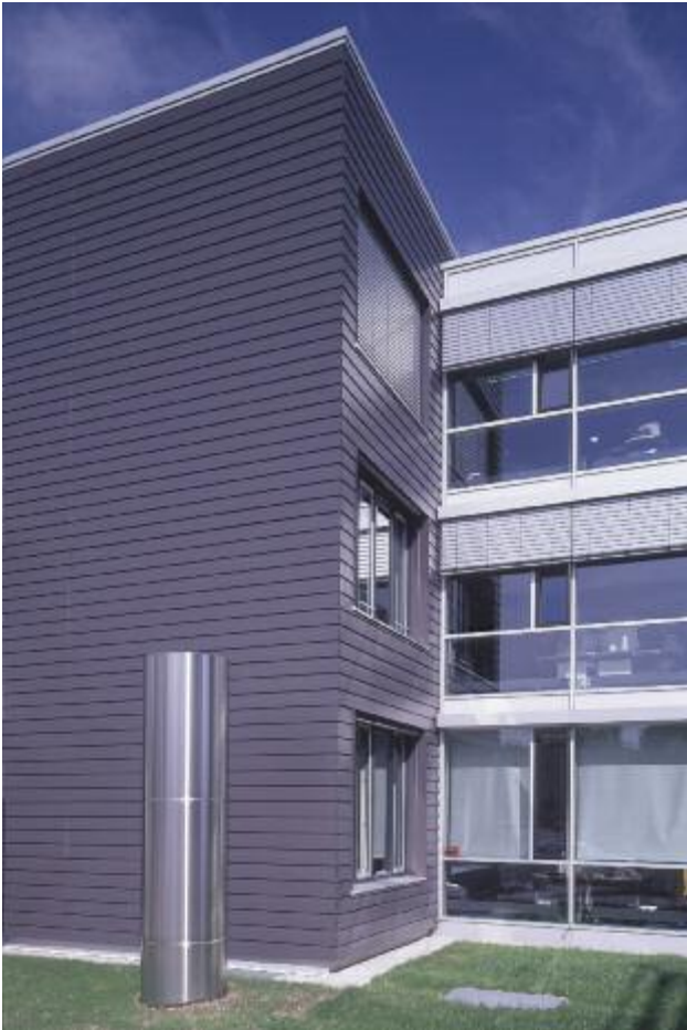
Kancelářská budova, Německo
