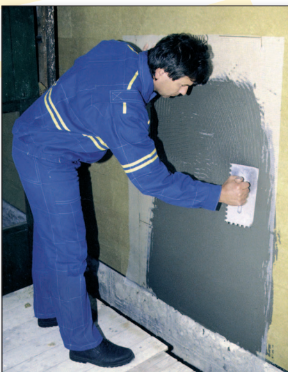
Uložení výztužné mřížky
