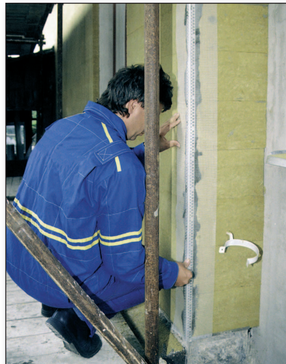
Zpevnění nároží rohovými lištami
