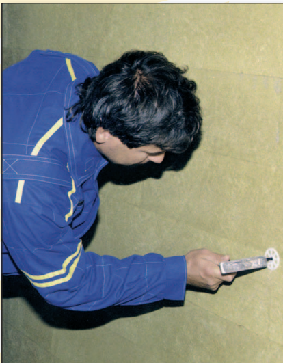
Kotvení talířovými hmoždinkami
