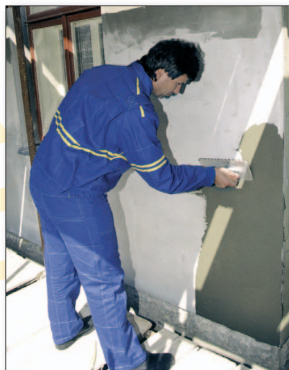
Nanášení krycí vrstvy tmelu
