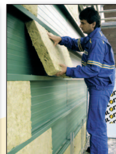
Vkládání tepelné izolace do kazet
