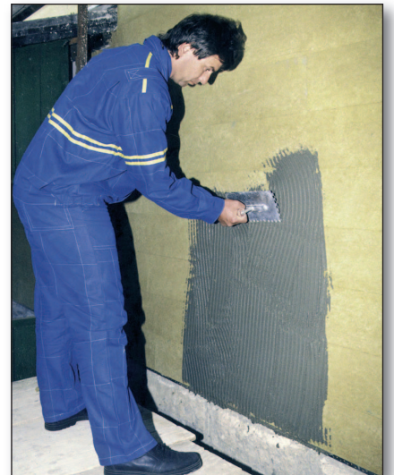
Nanášení vyrovnávací vrstvy tmelu
