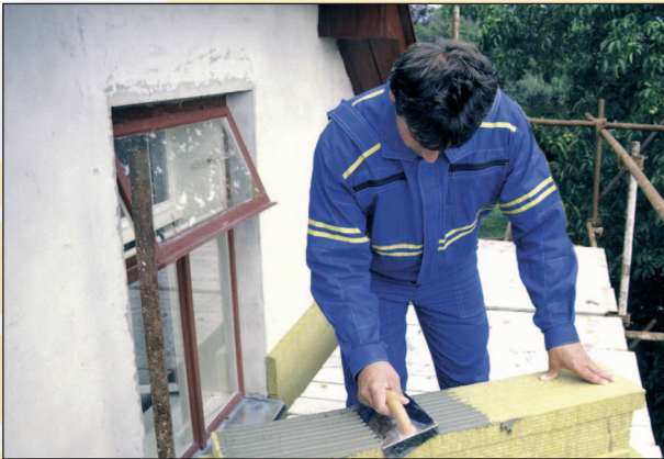
Nanášení tmelu na lamelu ORSIL NF
