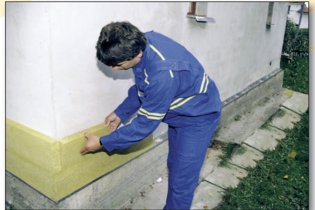
Lamely ORSIL se lepí na stěnu na vazbu s převázáním na rozích
