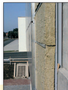
Vkládání tepelné izolace do kazet
