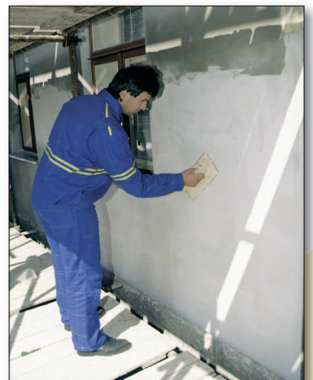
Provádění vrchní omítky
