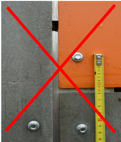
CHYBNĚ PROVEDENÁ DILATACE ROŠTU
