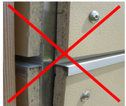
NEVYROVNANÝ PODKLAD POD DESKAMI
