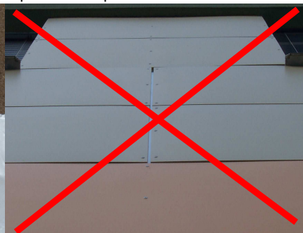
PŘEKROČENÁ VZDÁLENOST PODPOR
