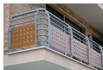
■ PERFORACE BALKÓNOVÝCH VÝPLŇÍ.
